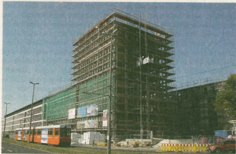
Für den 2. Bauabschnitt des Kontorhauses wurde Richtfest gefeiert. In der Mitte der Büroturm, rechts das Hotel an der Oker-Umflut.
